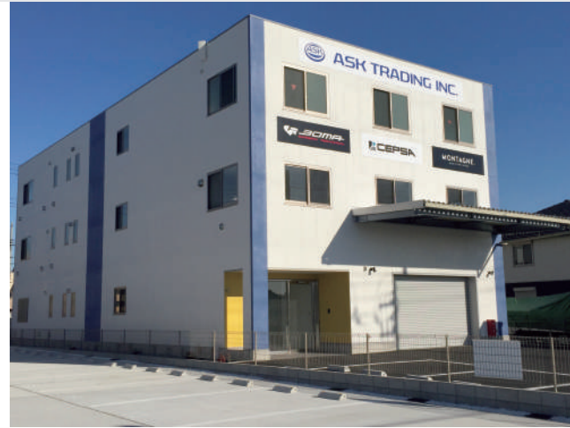
物流センター 2017 年 1 月稼働
